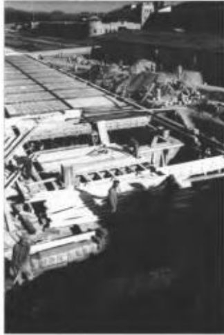
Construcción de edificios en la zona exterior del campo central de Mauthausen, destinada a la tropa de las SS. Foto: SS
